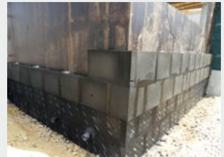
- Remblai sur l'isolant FOAMGLAS® - Jonction thermique entre la partie enterrée et la façade
