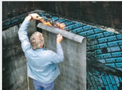
- Soudage d'une membrane bitumeuse sur l'isolant.
